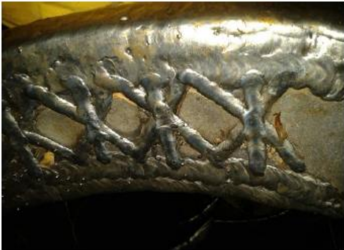
Recubrimiento con soldadura anti desgaste
