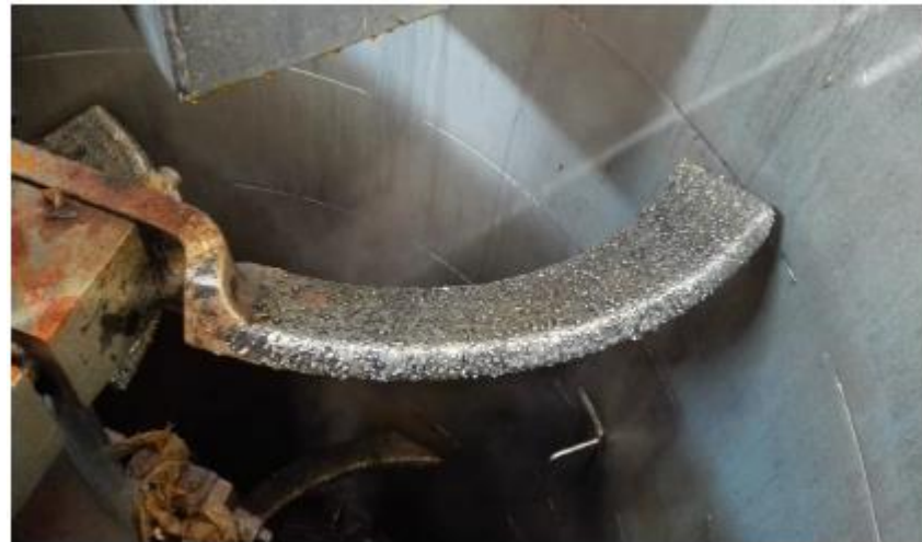
Brazos recubiertos con soldadura rugosa
