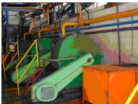
Foto 6. Palmeras de la Costa S.A. Centrífugas
